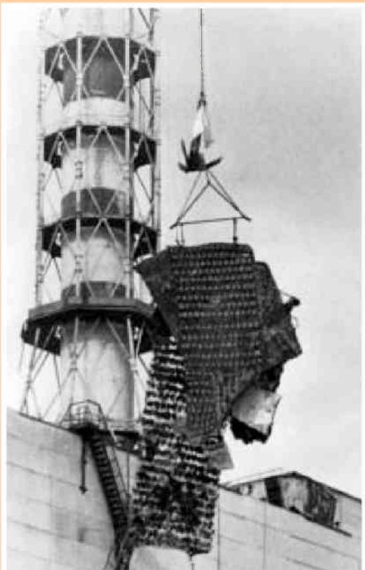
Съем клеевого захвата вместе с кусками кровли
