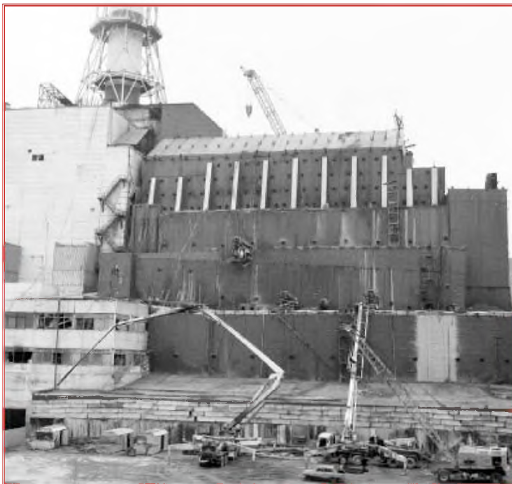
Монтаж "Укрытия" подходит к концу
