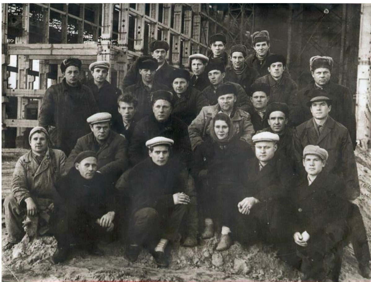
Бригада монтажников ЦЭМ на строительстве машинного отделения 1-го блока 1958 год.
